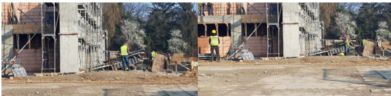
Kontrola legalności zatrudnienia na budowie
